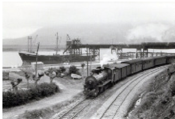
Fotografía del cargadero de Orconera y ferrocarril en Astillero. (Fuente: http://historiastren.blogspot.com/2012/11/los-ferrocarriles-de-la-orconera.html )
