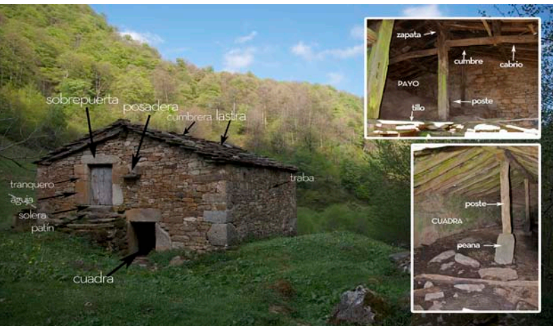
Partes de una cabaña tipo (según García Alonso, 1997) |
