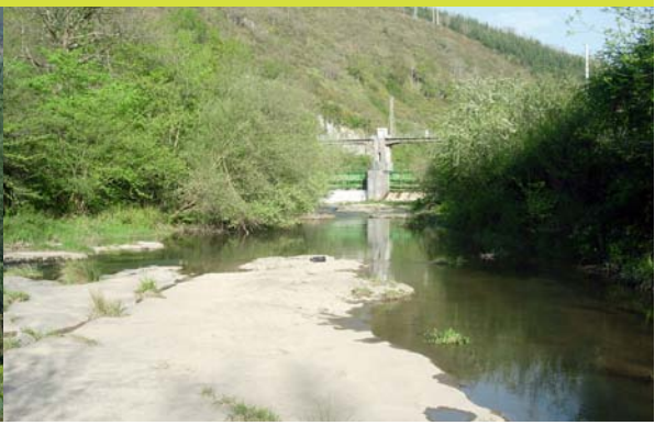
Superficie pulida del lecho aguas abajo del azud de Celis |
