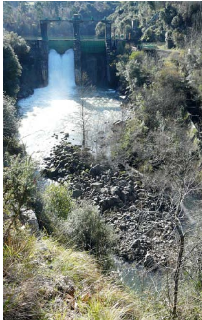
Zonas de sobreexcavación y de acumulación aguas abajo de la presa de Palombera
