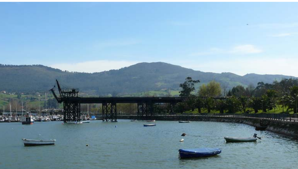
Cargadero de Orconera en Astillero, construido por José Mac Lennan en 1894 |
